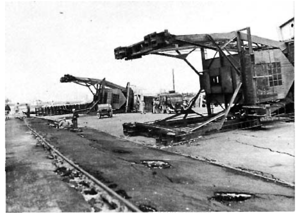
Photo 86. Grue renversée par l'affaissement du remblai, mur du quai nord. (U.S.Navy)
