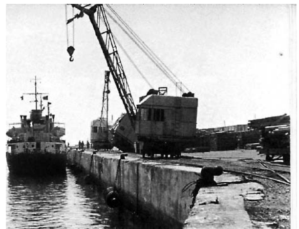
Photo 88. Effondrement d'une grue, le long du mur du quai ouest (U.S.Navy).
