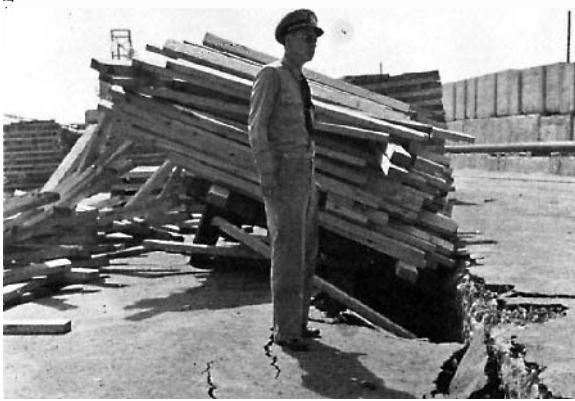
Photo 84. Effets de l'affaissement du remblai, le long du briselaimes de l'ouest (U.S.Navy).
