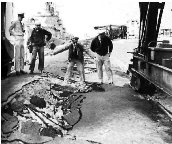
Photo 85. Effets de l'affaissement du remblai le long du mur du quai nord (U.S.Navy).
