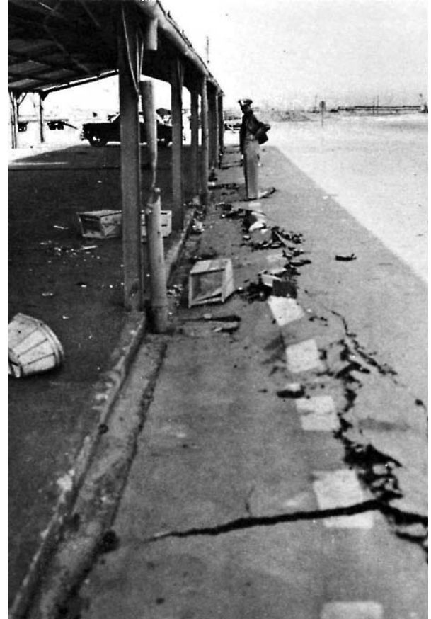
Photo 91. Affaissement de la structure de remise en armature d'acier (U.S.Navy).
