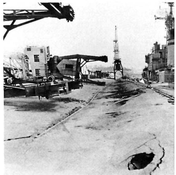
Photo 87. Basculement d'une grue, mur du quai nord (U.S.Navy).
