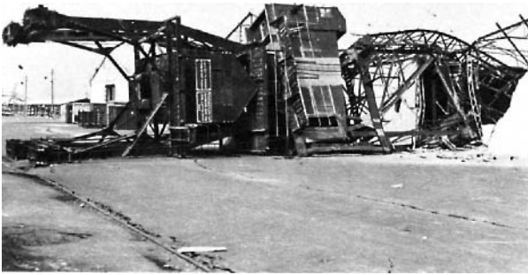
Photo 89. Bâtiment d'entrepôt écrasé par le renversement d'une grue (U.S.Navy).
