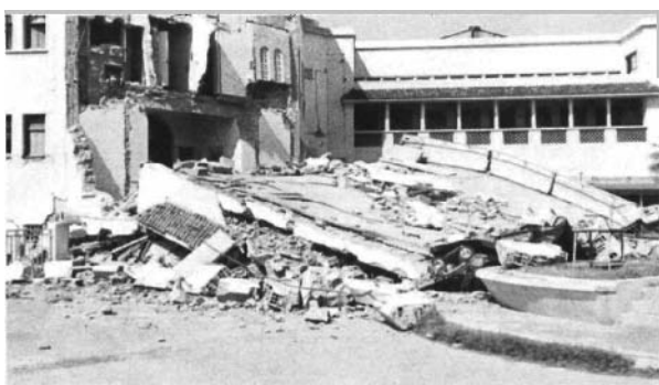
Photo 34. Dégâts du portique de l'hôtel Marhaba, cas typique de plusieurs exemples à Agadir
