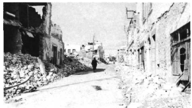
Photo 21. Après que la rue a été dégagée par les bulldozers
