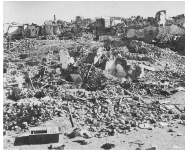
Photo 15. Effondrement d'une construction ancienne en maçonnerie, Yachech
