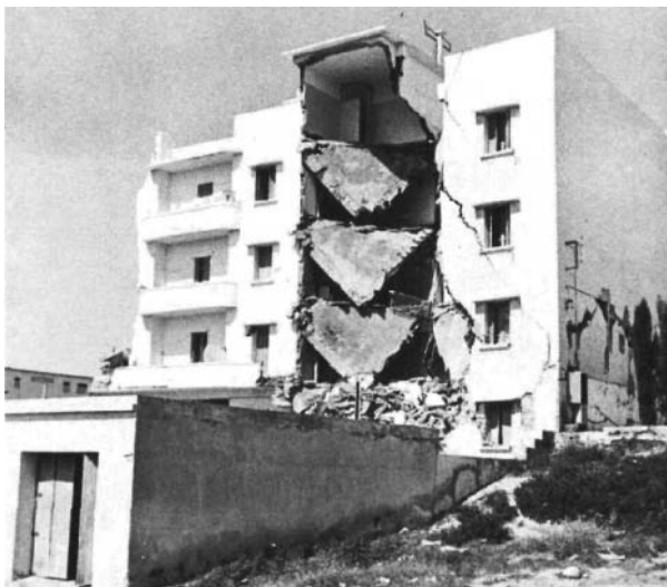
Photo 33. L'affaissement des murs porteurs en maçonnerie laisse les dalles de plancher sans support
