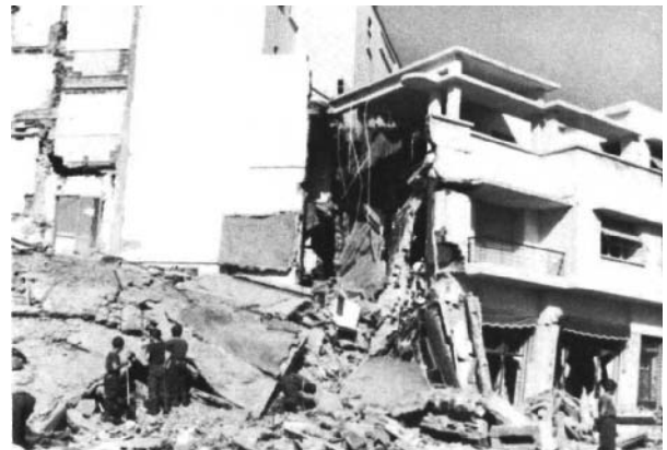
Photo 31. Effondrement d'une construction typique en maçonnerie de la Ville Nouvelle
