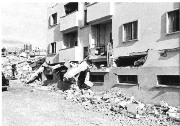
Photo 24. L'affaissement complet du rez-de-chaussée de l'immeuble montré sur la photo 22
