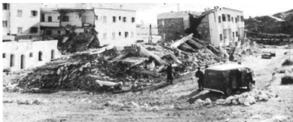
Photo 22. Effondrement d'un bâtiment en maçonnerie de 'Présentation moderne', Talbordjt
