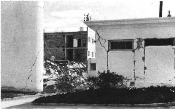
Photo 27. Aile du service de la maternité effondrée, Hôpital Lyautey
