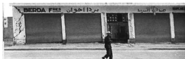
Photo 36. Notez l'effet de maintien des rideaux métalliques flexibles
