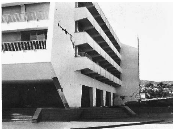
Photo 62. Immeuble La Paternelle face Sud-Est
