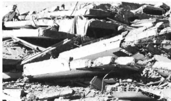
Photo. 41. Immeuble Consulaire, notez l'empilement de l'ensemble des dalles des planchers
