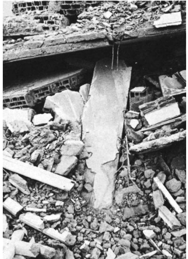
Photo 46 Caissons de plancher alvéolés préfabriqués, Hôtel Saada
