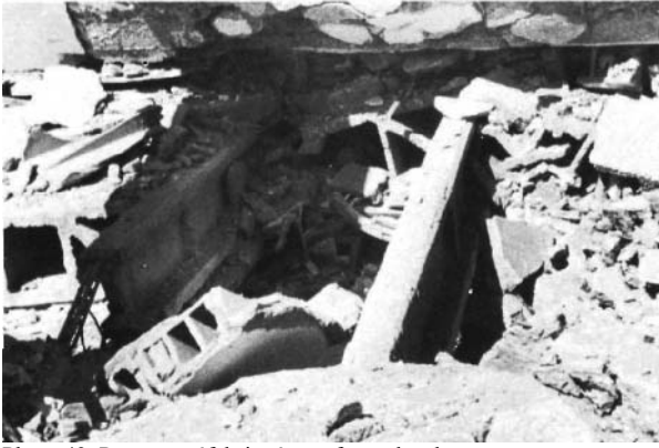
Photo 43. Poutres préfabriquées et faux-planchers
