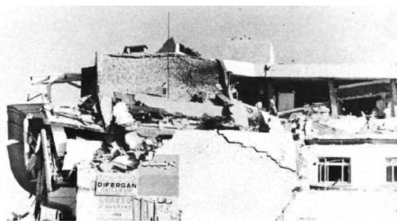
Photo 51. Sud-Building vu du NE, le déport de balcon est visible
