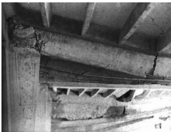
Photo 67. Détail démontrant la grande élasticité de l'ossature du Marché.
