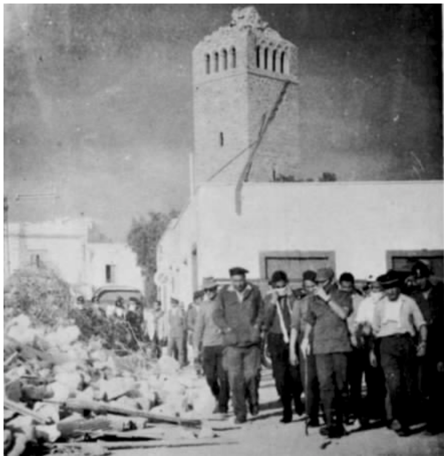
Le Colonel Driss (à droite) inspecte les ruines avant le bouclage.
